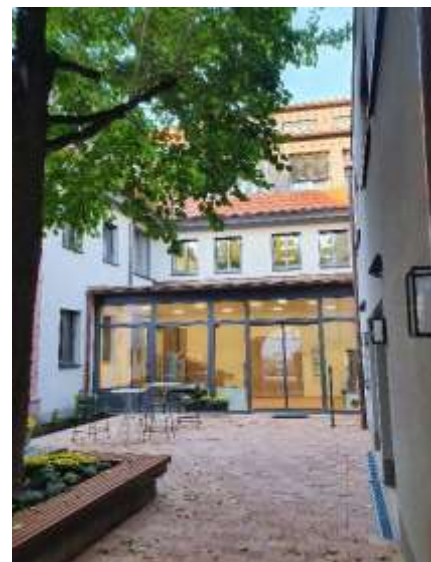
Bilder: Erneuerung Rathaus Teningen
